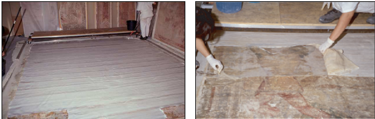
Figura 8. Applicazione e rimozione di impacchi contenenti Pseudomonas stutzeri A29 sulla superficie dell'affresco "La Conversione di S. Efsio e battaglia" di Spinello Aretino del XIV secolo presente nel Camposanto Monumentale di Pisa.
