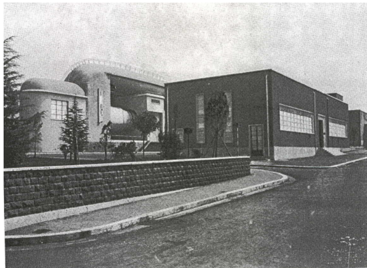
Figura 2 Edifici delle gallerie a doppio ritorno e ultrasonora [11]
