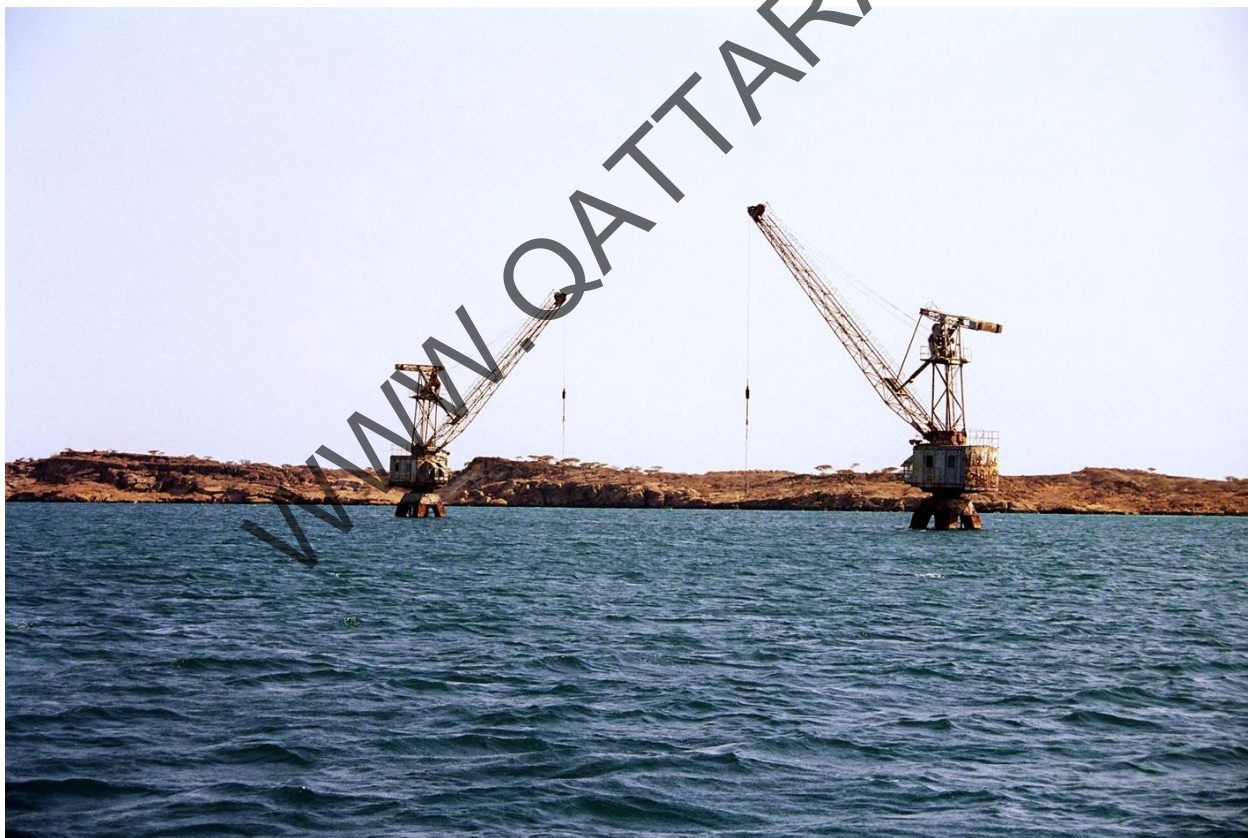
Nokra: le gru del bacino galleggiante, ancora visibili nel 2000 (foto dell'Autore)
